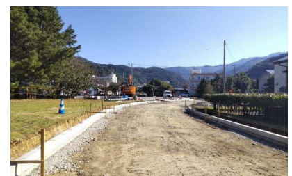
④道路付替工事状況
