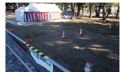
③建築工事の準備状況
